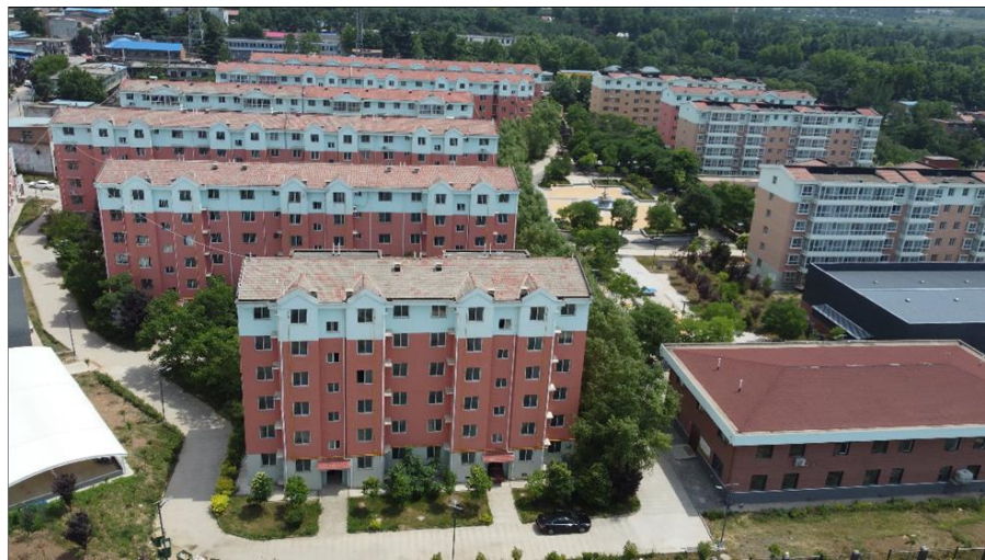
桥南镇新能源站北侧
