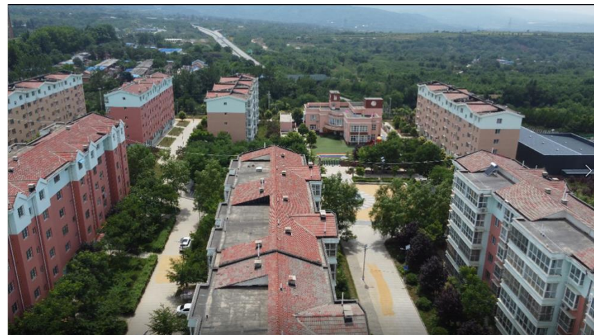
桥南镇新能源站东侧
