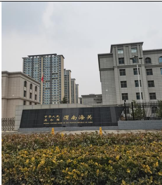
东北侧渭南海关
