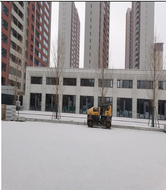
东侧商铺和住宅楼
